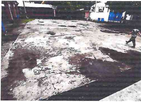
Foto 1: LOSA DE PATIO
